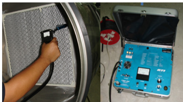
รูปที่ 5.3 การตรวจเช็คครอยรั่วของ HEPA filter ด้วย photometer
