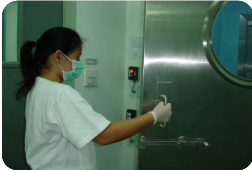
รูปที่ 12.1 เปิดประตูด้าน secure zone นำของที่ต้องฆ่าเชื้อใส่ใน decontamination chamber
