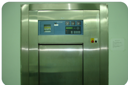
รูปที่ 6.1 เครื่องนึ่งฆ่าเชื้อแบบ 2 ประตู (2 door-autoclave)
